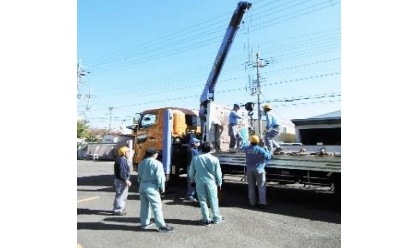
2016.10 クレーンを用いた検査(大東市)
