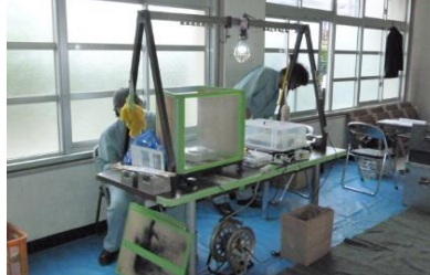
2014.6 第五中学校(吹田市) *下足置場
