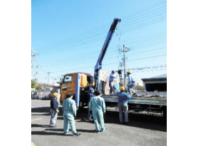
クレーンを用いた2tの吊りはかりの検査
